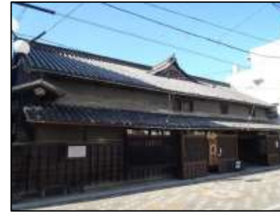
【写真-1 景観重要建築物(伊予市宮内家主屋)】
