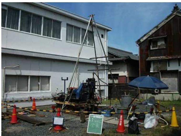
写真-3.1.1 ボーリング機械設置状況及び仮囲い
