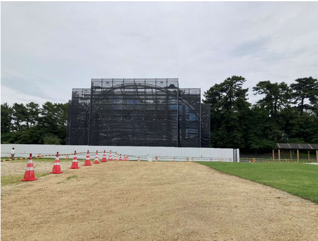
4 野外ステージ屋根施工状況 (6月26日現在) 屋根面積 A=350m 2
