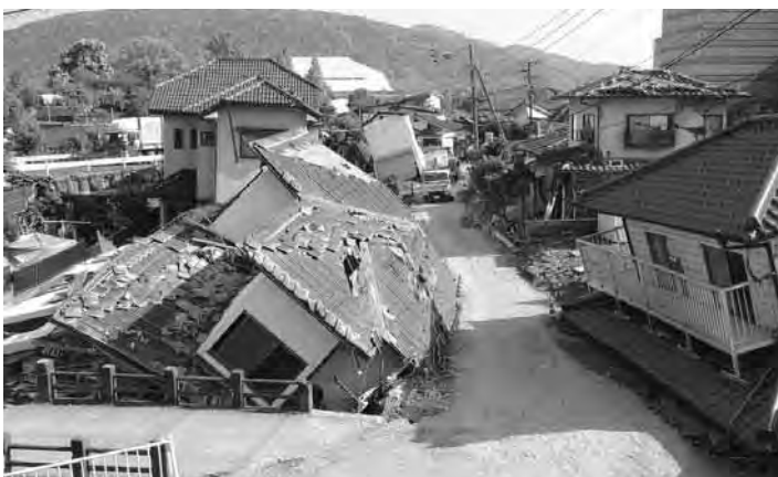
▲熊本地震による被害
