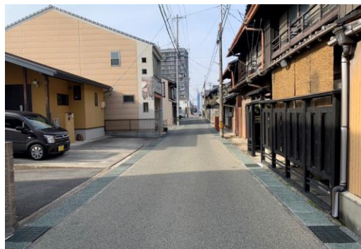
↓工事後の道路美装化箇所(片町1丁目)
