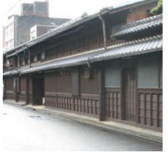
伊藤家住宅(名古屋・四間道)
